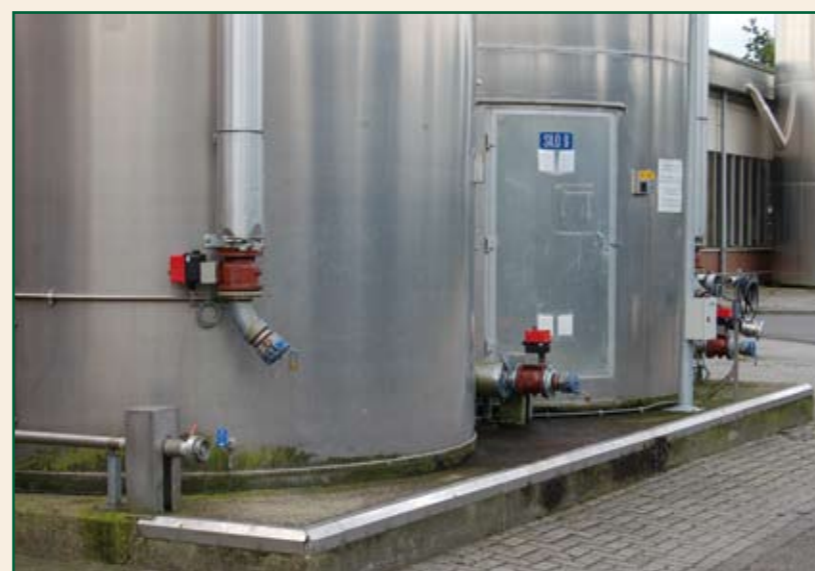
Twee van de twaalf buitensilo's, met afsluitkleppen op de ingaande pijp ter voorkoming van foutieve vulling.
