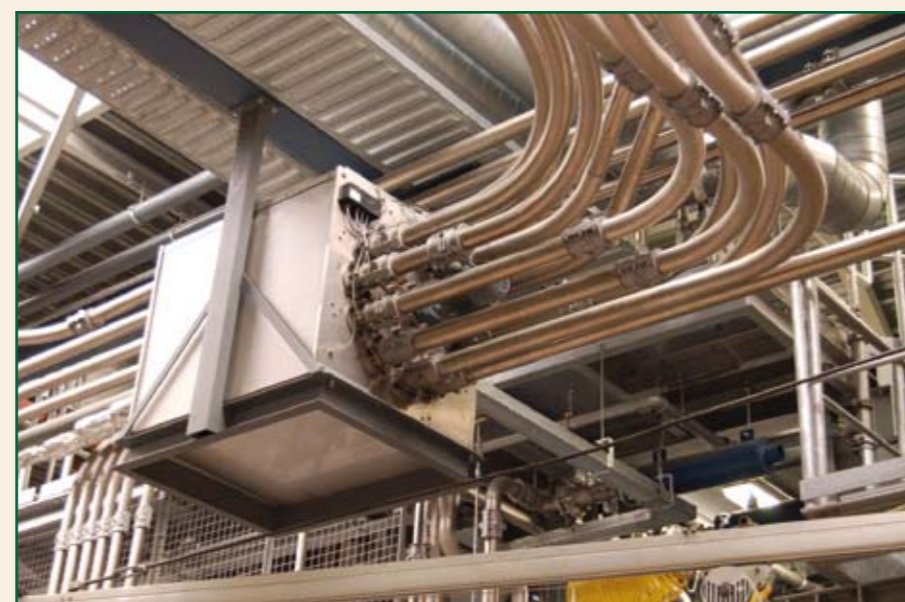
Eén van de wisselstations voor de sturing van het granulaat naar de juiste binnensilo's
