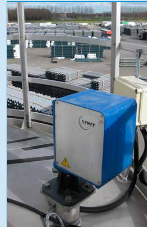
De peilloodmeter, bovenop de silo gemonteerd
