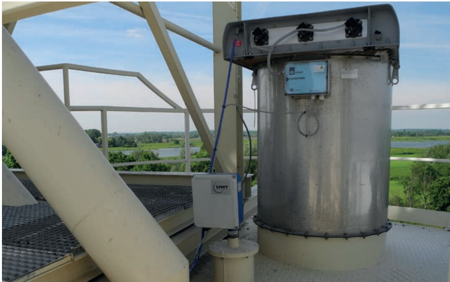
Afb. 1 Voor de niveaumeting van lichte, stoffige materialen maakt Pull Rhenen gebruik van de Nivobob peillood-niveaumeter van UWT Level Control
