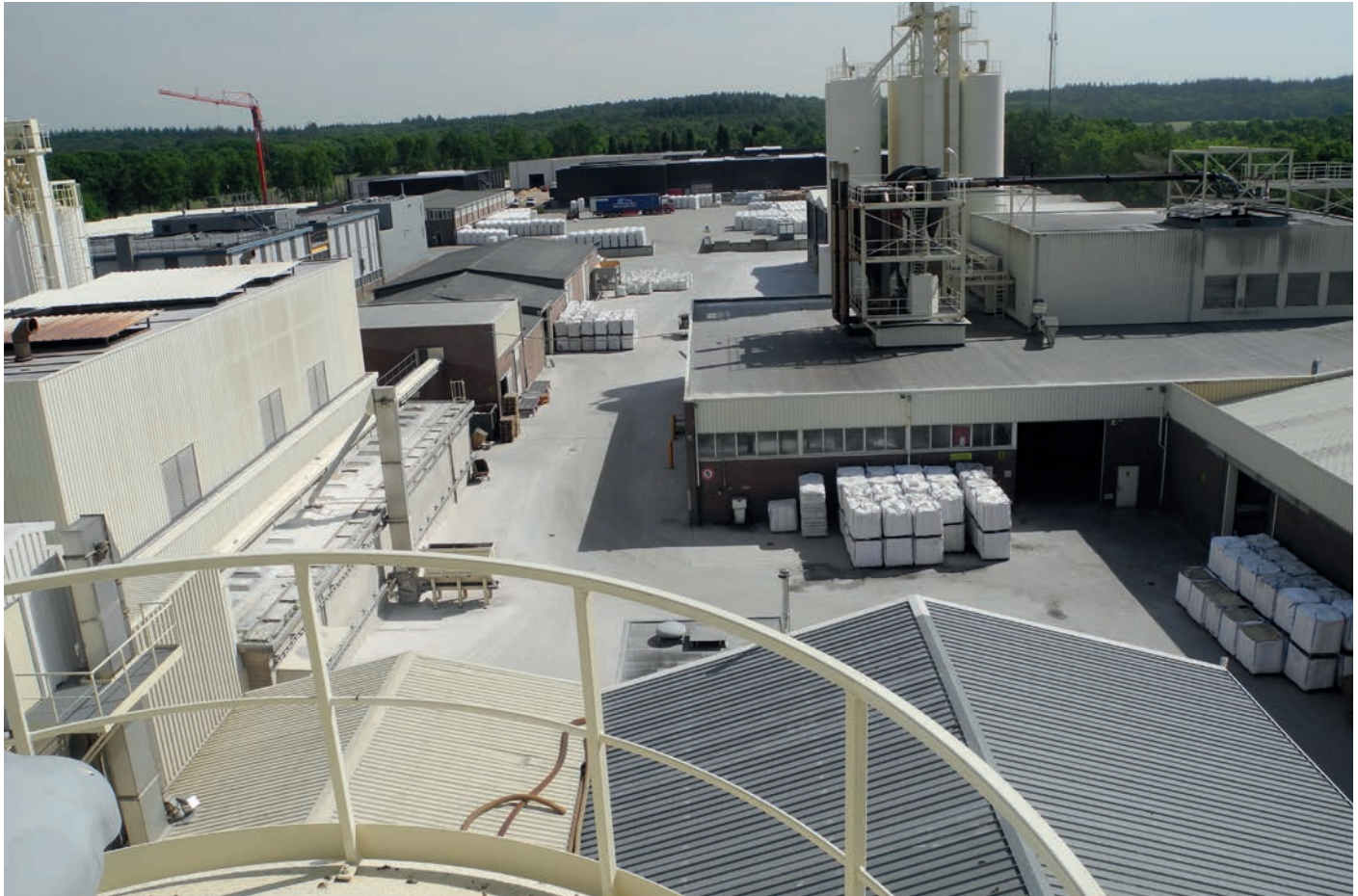
Afb. 4 Het terrein van Pull Rhenen gezien vanaf een silodak
